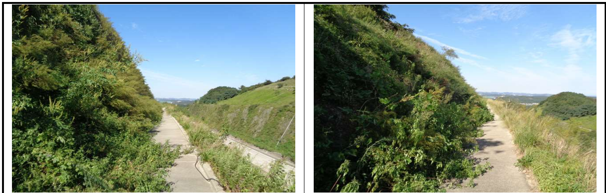
【그림 1.3.3】 배수시설 전경
